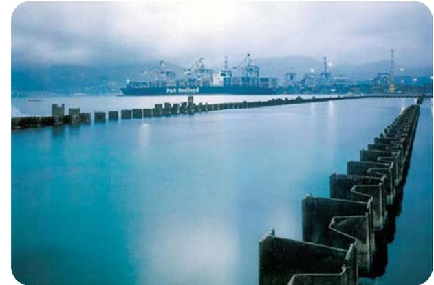
Figura 11. Imagem ilustrativa da estrutura de contenção a ser utilizada: estaca-prancha. Fonte: Google Imagens, 2013.
